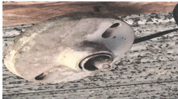
Foto 8: Sustitución de focos ahorradores
