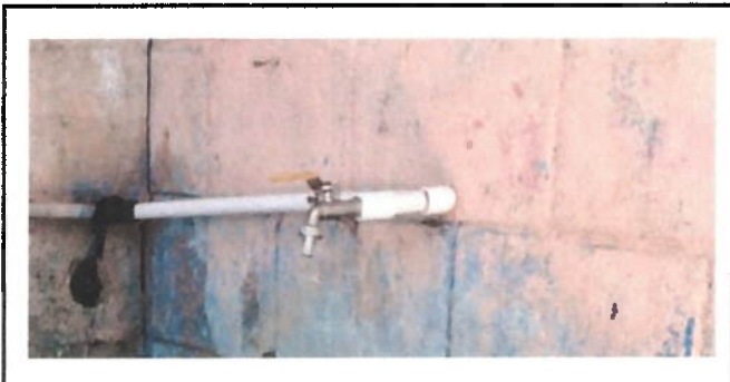
Foto 6: Sustitución de grifo
