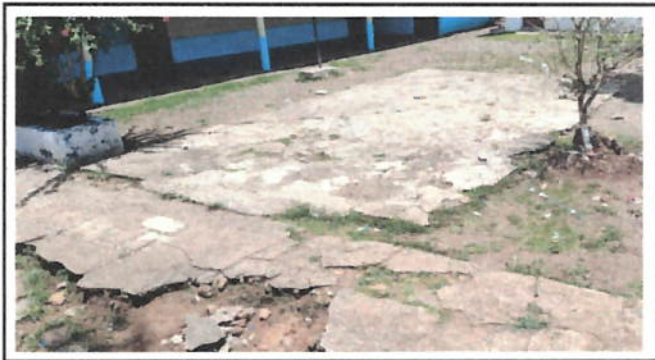
Foto 4: Sustitución de piso de torta de concreto
