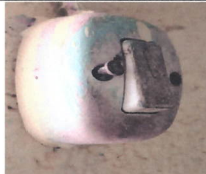
Foto 10: Sustitución de apagadores
