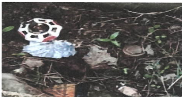
Foto 7: Sustitución de llave de paso
