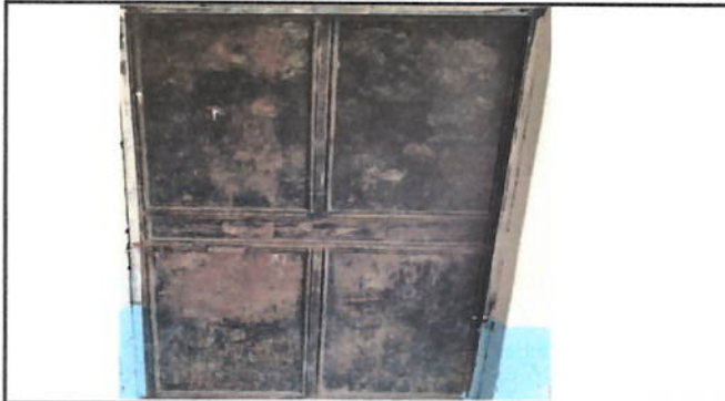
Foto 1: Mantenimiento a estructura (lijado, aplicación de pintura)
