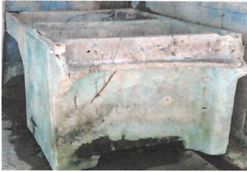
Foto 13: Sustrucción de pila de cemento de dos lavadero
