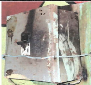
Foto 11: Sustitución de flipones
