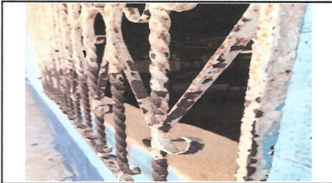
Foto 3: Sustitución de balcones de metal
