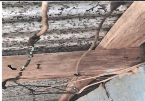
Foto 12: Reparación de cableado eléctrico
