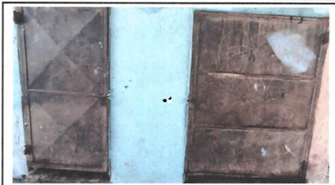
Foto 2: Sustitución de puerta
