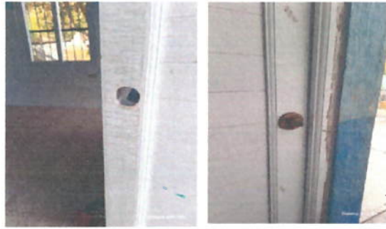
Foto 2: Sustitución de chapa
