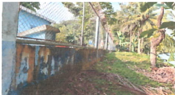
Foto 1: Reparación de muro perimetral de block
