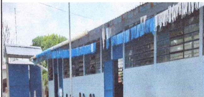
Foto 3: Sustrucción de canal de pvc con soportes de metal.
