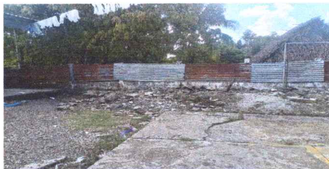
Foto 6: Repello en muro.
