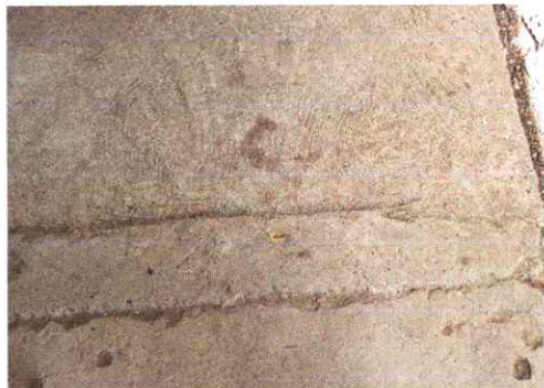
Foto 7: Sustitución de piso de torta de concreto
