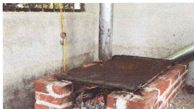
Foto 4: Sustrucción de plancha de metal de 3 hornillas
