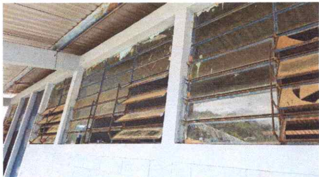
Foto 1: Sustrucción de balcones de metal
