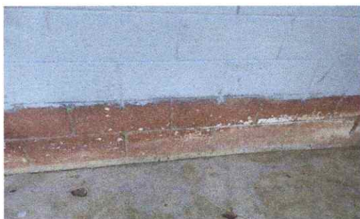
Foto 5: Pintura de muros exteriores e interiores.
