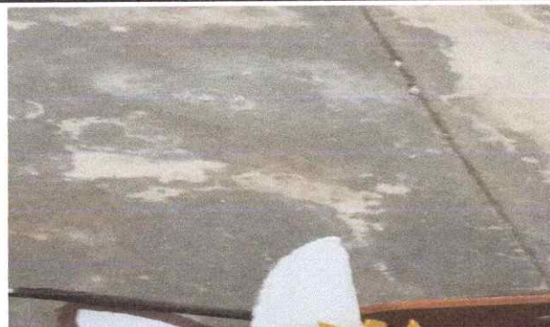
Foto 2: Sustrucción de piso de torta de concreto.
