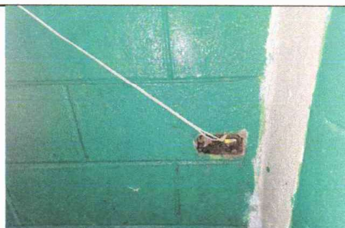
Foto 3: Reparación del sistema eléctrico
