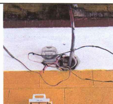
Foto 4: Reparación del sistema eléctrico
