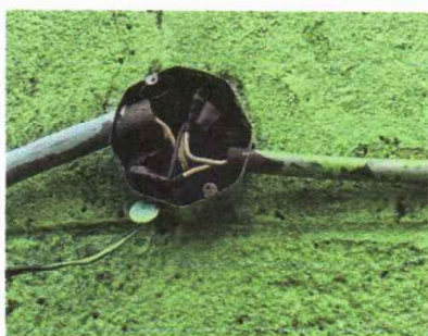
Foto 1: Reparación del sistema eléctrico
