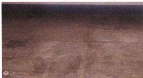
Foto 3: Reparación de piso de torta de concreto
