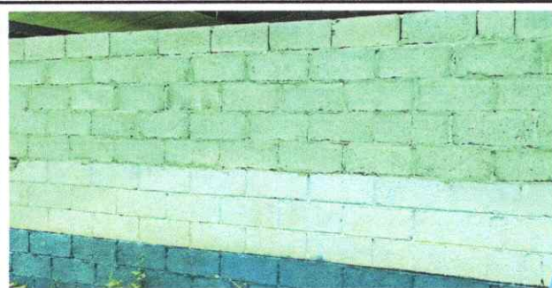
Foto 5: Repello en muro interior e exterior
