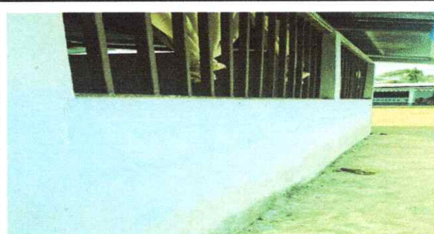
Foto 2: Pintura en muros exteriores e interiores
