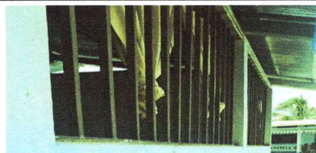
Foto 4: Mantenimiento a balcones de metal
