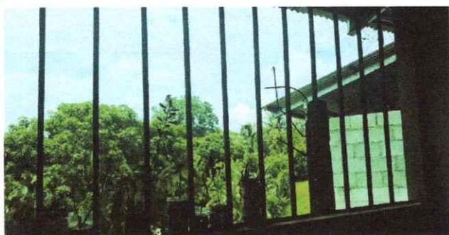
Foto 3: Sustitución de estructura de metal de ventana
