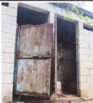
Foto 3: Mantenimiento a estructura (lijado, cambio de tubo , cepillado, sujeciones, aplicación de pintura) a puertas servicios sanitarios
