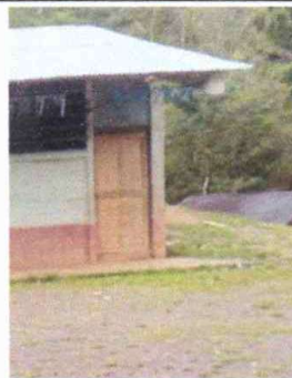
Foto 2: Sustitución de puerta
