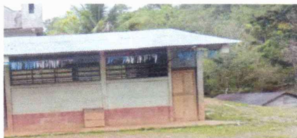
Foto 4: Pintura en muros exteriores e interiores
