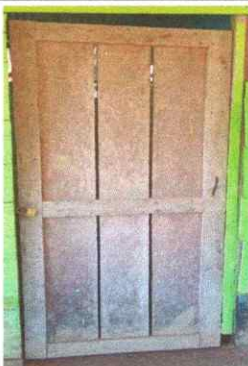
Foto 3: Sustitución de puerta de (2.10m de alto *1.00 m ancho)
