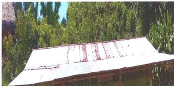
Foto1: Sustitución de techo de manaca por lámina aluzinc calibre 26
