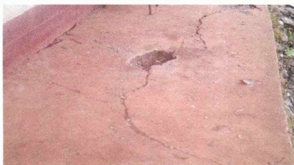
Foto 3: Reparación de piso de cemento
