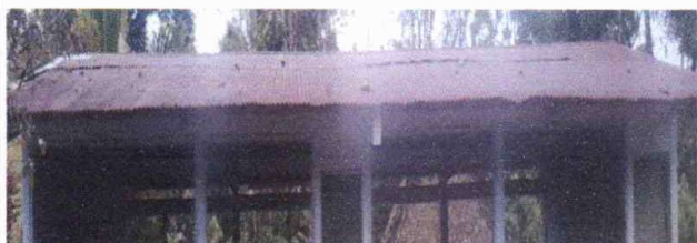
Foto 1: Sustrucción de lámina, por lámina troquelada aluzinc calibre 26
