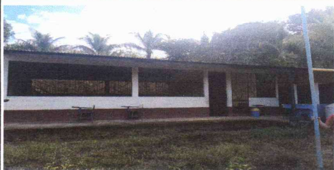
Foto 7: Pintura en muros exteriores e interiores
