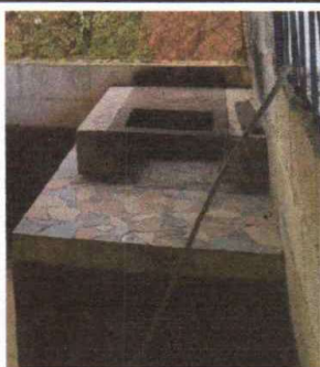
Foto 5: Sustitución de plancha de metal de 2 hornillas
