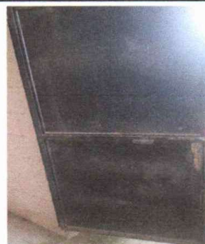
Foto 4: Mantenimiento a estructura de Puertas de Aula, Cocina y Baños
