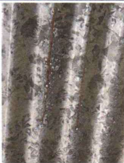
Foto1: Sustitución de lámina, por lámina troquelada calibre 26
