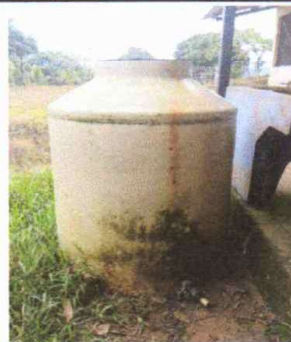
Foto 6: Sustitución de deposito de agua 2500 lt
