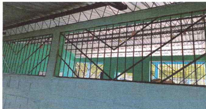
Foto 2: Mantenimiento a balcones de metal
