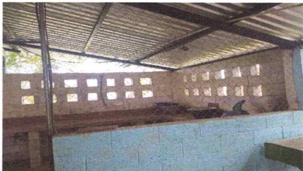
FOTO 7: Fabricación e Instalación de balcones de metal en cocina
