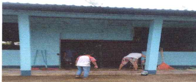
Foto 4: Pintura en muros exteriores e Interiores
