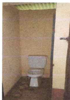
Foto 5: Sustrucción de Inodoros
