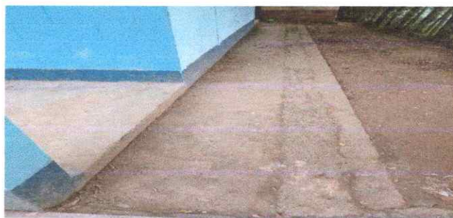
Foto 6: Reparación de Planchas de concreto de patio
