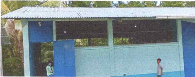
Foto 1: Sustrucción de lámina, por lámina troquelada aluzinc calibre 26
