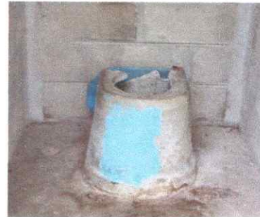
Foto 4: Sustrucción inodoro de cemento por inodoro lavable
