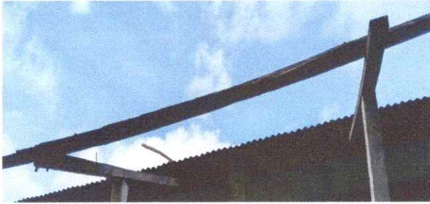
Foto 7: Sustitución de estructura de soporte de madera, por metal (pasillo exterior del aula)
