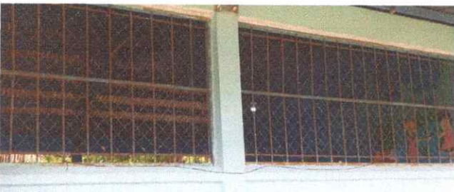
Foto 3: Sustrucción de balcones de metal
