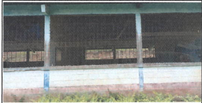
Foto 4: Mantenimiento a balcones de metal
