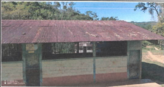
Foto1: Sustitución de lámina, por lámina troquelada calibre 26
