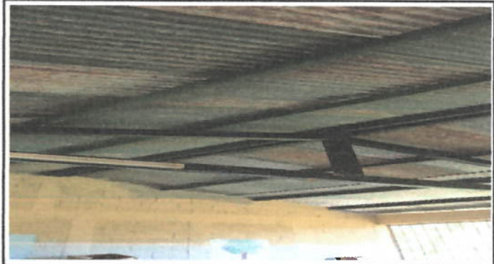
Foto 2: Mantenimiento a estructura de soporte de metal
