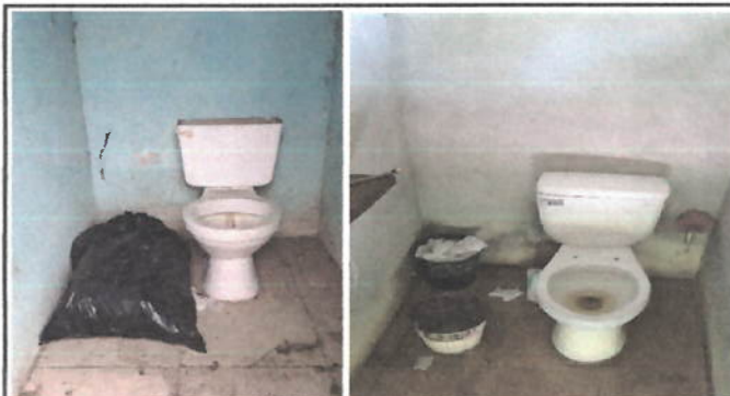
Foto 4: Sustitución inodoro e Instalación de inodoro
