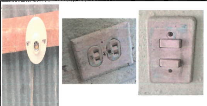
Foto 5: Sustitución de focos ahorradores, Sustitución interruptores dobles y Sustitución de tomacorrientes dobles
