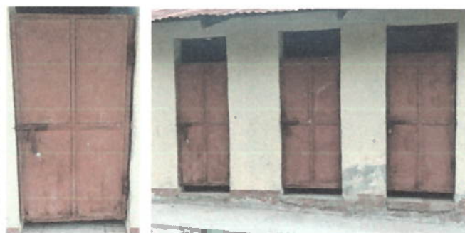
Foto 2: Sustitución de Puertas y Mantenimiento a estructura (lijado, cambio de tubo , cepillado, sujeciones, aplicación de pintura)
