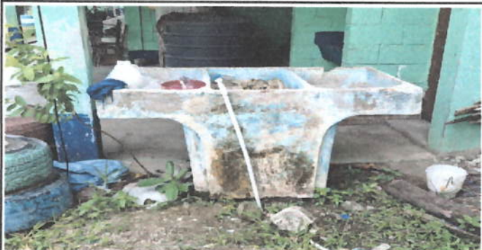
Foto7: Sustitución de pila de cemento de dos lavadero
