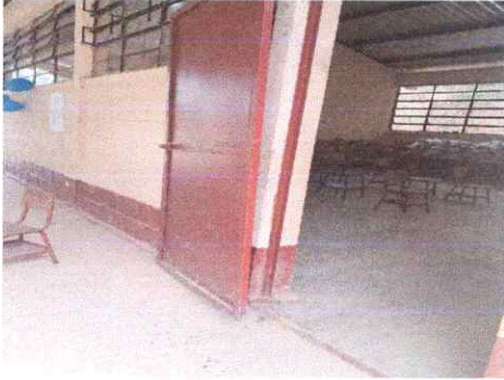
Foto 1: Sustitución de puerta de Aula
