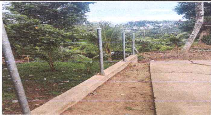
Foto 3: Reparación de tubo hg y malla galvanizada
