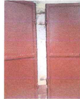
Foto 2: Sustitución de Puertas en Servicios Sanitarios
