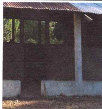
Foto 4: Fabricación e instalación de puertas de metal
