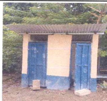
Foto 6: Sustitución de puerta en servicios sanitario
