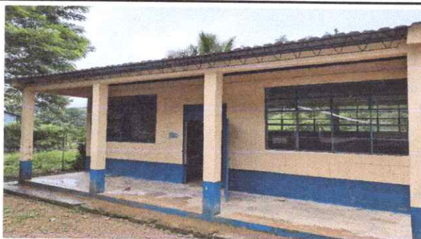
Foto 5: Sustitución de estructura de metal de ventana
