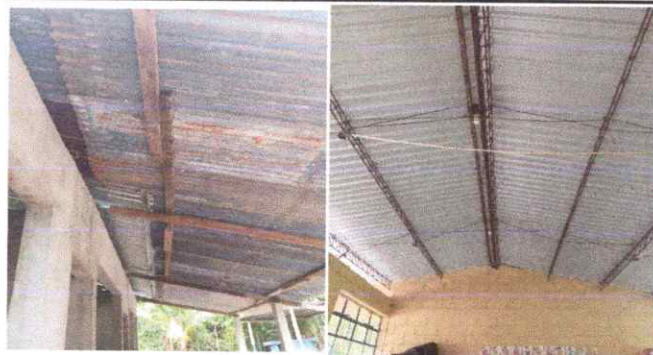
Foto 2: Sustitución de estructura de soporte de madera por metal Y Sustitución de estructura de soporte de metal por metal.
