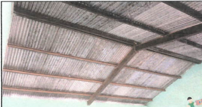
Foto 3: Sustrucción de estructura de soporte de metal, por metal (COSTANERAS)
