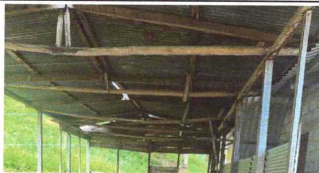
Foto 2: Sustitucion de estructura de madera a metal
