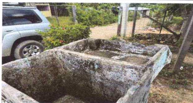
Foto 6. Sustitución de pila de concreto de dos lavaderos
