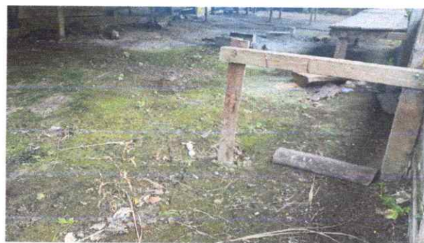
Foto 4: Sustitución de piso de concreto
