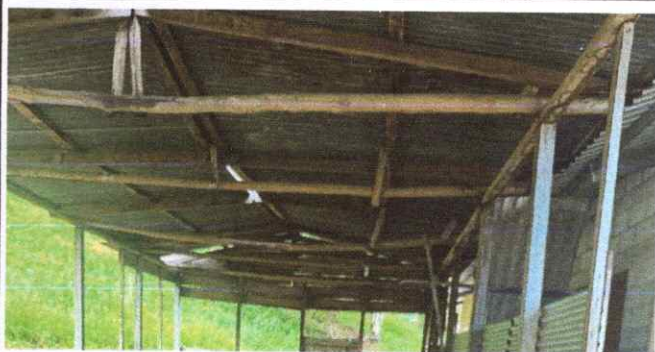
FOTO 1: sustitución de LÁMINA trouelada aluzinc calibre 26
