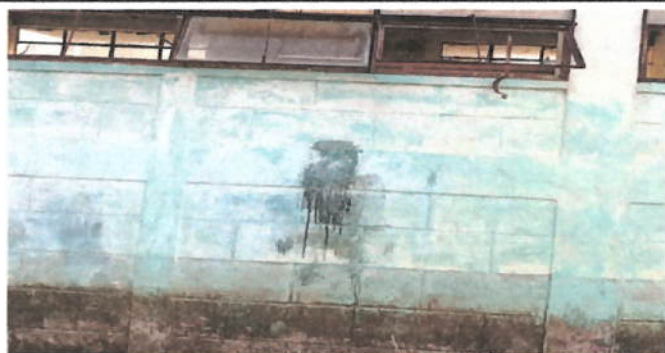
Foto 5: Pintura en muros exteriores e interiores
