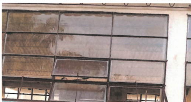
Foto 3: Sustrución de estructura de metal de ventana
