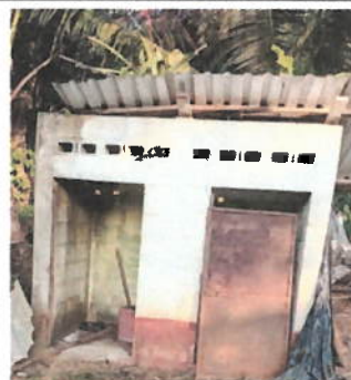
Foto 4: Mantenimiento a estructura (lijado, cambio de tubo , cepillado, sujeciones, aplicación de pintura) a puertas servicios sanitarios
