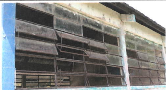
Foto 3: Sustitución de persianas de vidrio por balcones de metal
