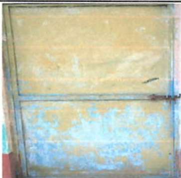
Foto 1: Mantenimiento a estructura (lijado, aplicación de pintura)
