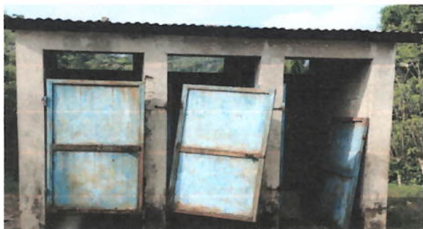
Foto 7: Desinstalación de lámina existente de servicios sanitarios
