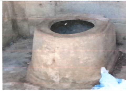
Foto 4: Sustitución de letrinas de cemento por inodoro
