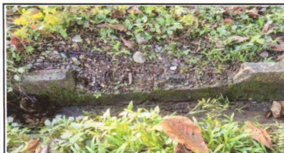
Foto 5: Reparación de cuneta de concreto
