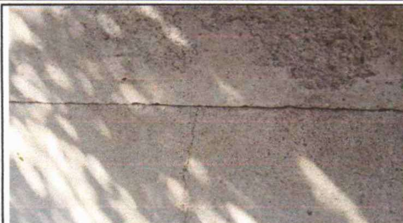
Foto 2: Reparación de piso de torta de concreto
