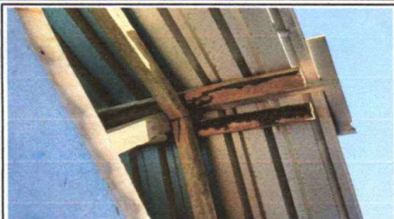
Foto 1: Sustrucción de cubierta de lámina.
