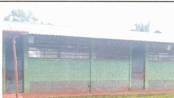
Foto 4: Pintura en muros exteriores e interiores
