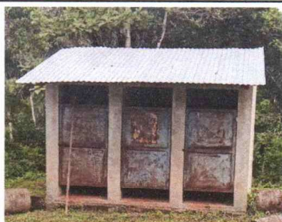
Foto 5: Mantenimiento a estructura (lijado, cambio de tubo , cepillado, sujeciones, aplicación de pintura) a puertas servicios sanitarios
