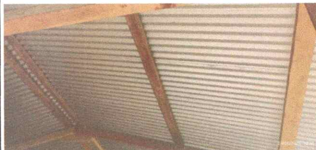
Foto 2: Sustrución de estructura de madera por metal
