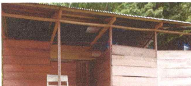
Foto 3: sustrución de circulación de madera por 3 hiladas de block y madera con malla galvanizada
