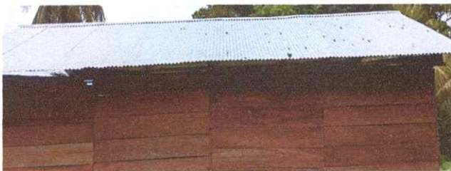
Foto 1: Sustrución de lámina, por lámina troquelada aluzinc calibre 26
