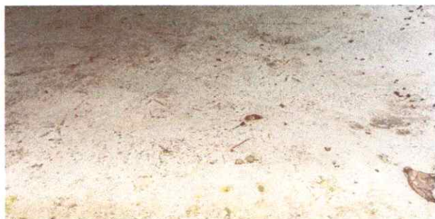
Foto 5: Sustrución de piso de torta de concreto
