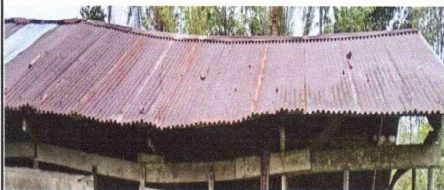
Foto 3: Sustitución de lámina, por lámina troquelada aluzinc calibre 26
