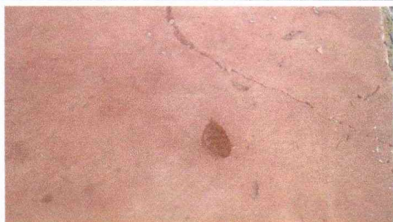
Foto 5: Reparación de piso de torta de concreto
