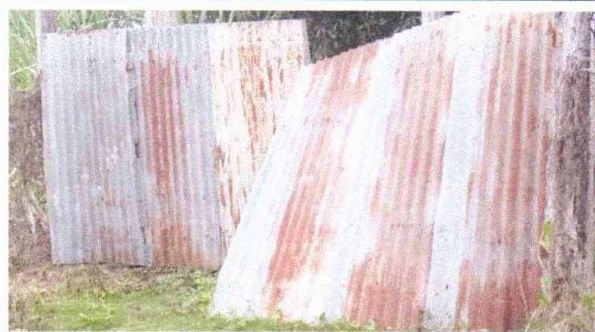
Foto 2: Sustitución de portón de lámina por metal con base de cemento
