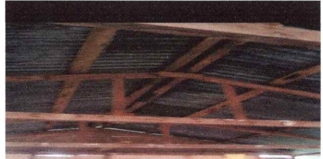
Foto 2: Sustitución de estructura de soporte de metal
