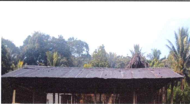
Foto1:Sustitución de techo de manaca por lámina aluzinc calibre 26
