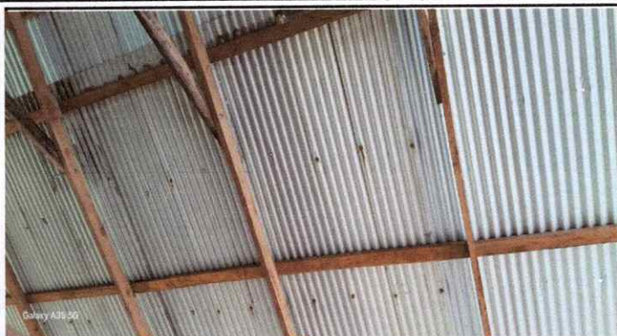
Foto1: Cambio de estructura del corredor principal
