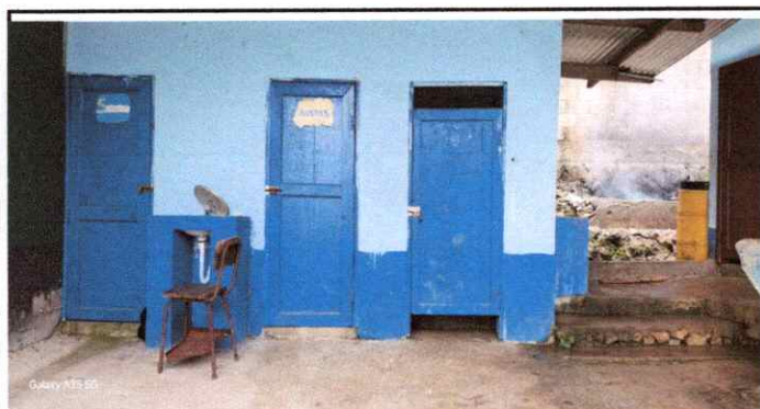
Foto 3: Sustitución de puerta en servicios sanitarios
