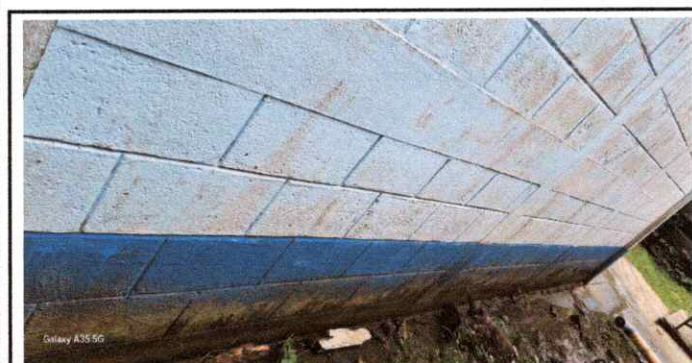
Foto 5: Pintura en muros exteriores e interiores
