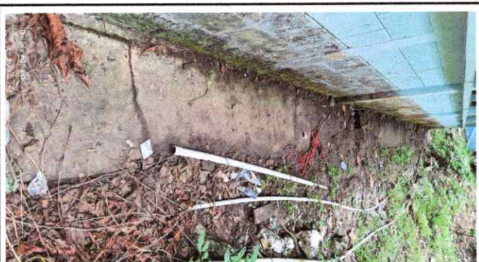
Foto 4: Reparación de cuneta de concreto
