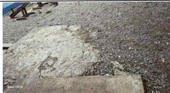
foto2: Sustitución de piso de torta de concreto
