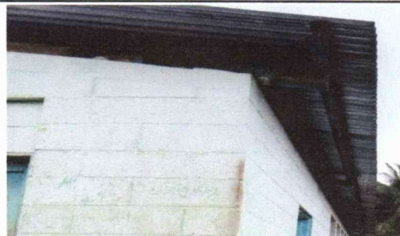
Foto 2: Mantenimiento a estructura de soporte de metal
