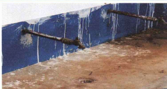
Foto 6: Sustrucción de llave de chorro
