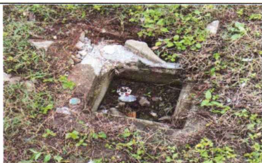
Foto 5: Sustrucción de tubería línea principal
