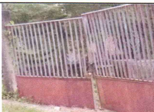
Foto 4: sustitución de porton de metal
