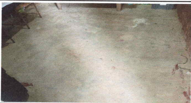
Foto 5: Sustrucción de piso de cemento por Ceramica
