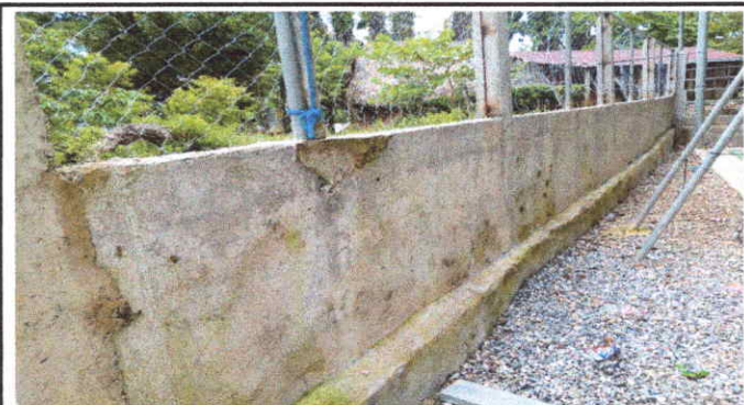
Foto 9: Pintura en Muros Exteriores e Interiores
