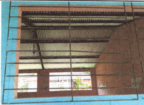
Foto 3: Sustrucción de balcones de metal
