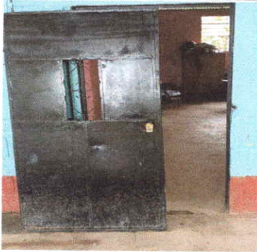
Foto1: Sustrucción de puertas
