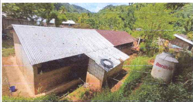
Foto1:Sustitución de lámina, por lámina troquelada aluzcinc calibre 26
