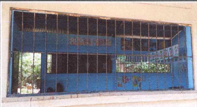
Foto 3: Mantenimiento a balcones de metal
