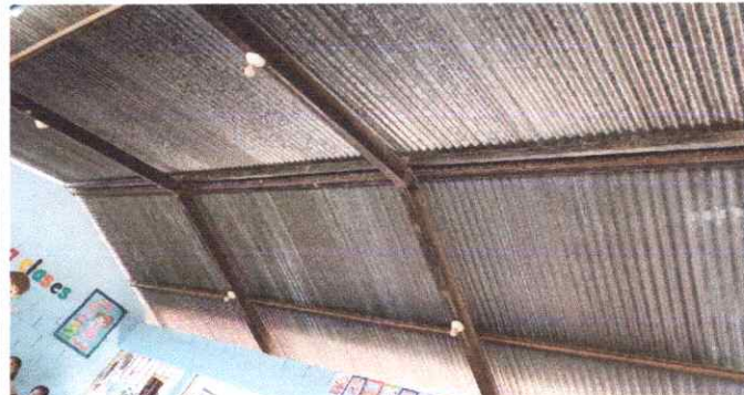
Foto 2: Mantenimiento a estructura de soporte de metal
