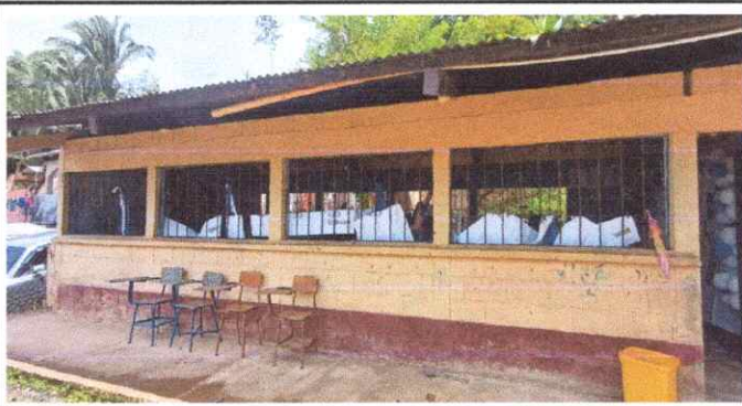
Foto 4: Pintura en muros exteriores e interiores
