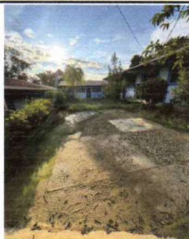
Foto1: Reparación y levantamiento de plancha de concreto.
