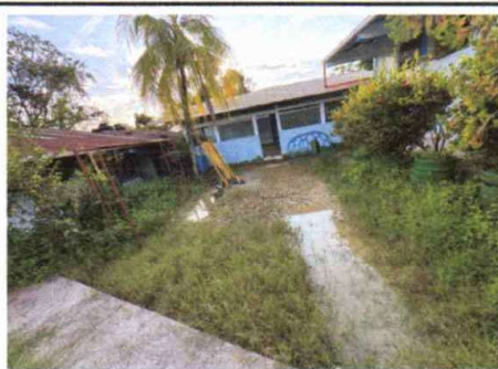
Foto 2: Reparación y levantamiento de plancha de concreto.
