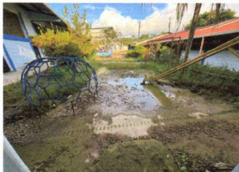
Foto 3: Reparación y levantamiento de plancha de concreto.
