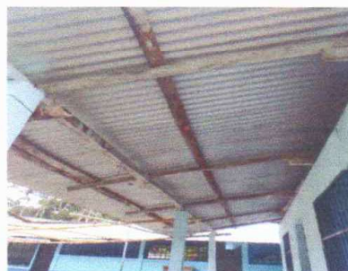
Foto 2: canales y bajada de agua
