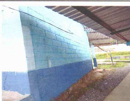
Foto 2: sustitucion de cuneta de concreto
