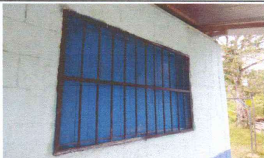
Foto 3: reparacion de ventanas y balcones
