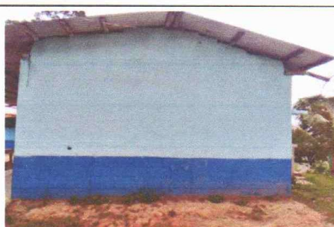
Foto 6: repello de las paredes de exterior
