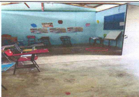
Foto1: sustitucion de piso ceramico
