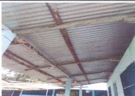
Foto1: sustitucion dde estructura de techo
