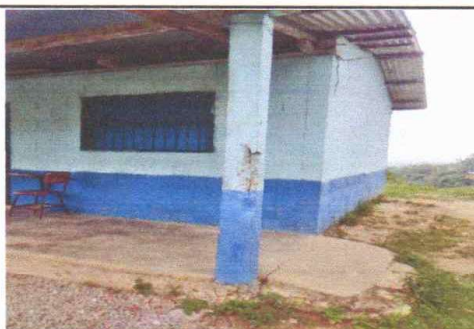
Foto 5: reparacion de columnas
