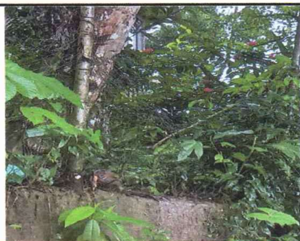
Foto 3: PARTE DE ATRÁS DEL ESTABLECIMIENTO EN MAL ESTADO
