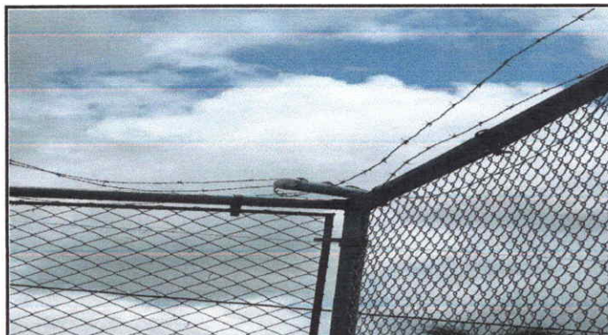
FOTO. No. 4 EPARACION DE MURO PERIMETRAL CON ALAMBRE DE RAZOR RIBBON
