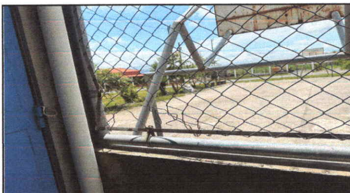
FOTO No. 3 REOARACUIN DE MURO PERIMETRAL DE MALLAY TUBO GALVANIZADO
