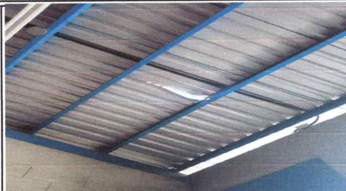
Foto1: SUSTITUCION DE LAMINA TROQUELADA
