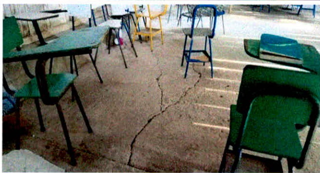
Foto 3: sustitución de piso de cemento líquido
