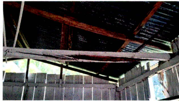
Foto 2: sustitución de soporte de madera por madera
