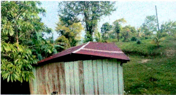
Foto1: Sustitución de lamina por lamina troquelada calibre 26
