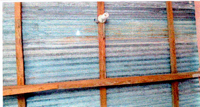
Foto 2: SUSTITUCIÓN DE SOPORTE DE TECHO DE MADERA POR METAL
