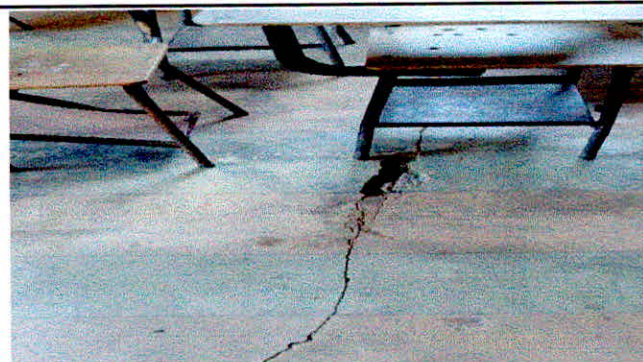
Foto 3: SUSTITUCIÓN DE PISO CERAMICO
