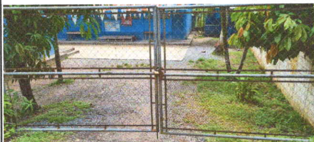
MANTENIMIENTO DE PORTONES: Renglón 12.1 Mantenimiento a portones de metal.
