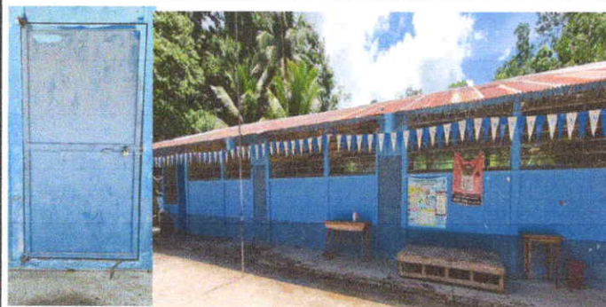
PUERTA DE METAL: Renglón 4.1 Mantenimiento a estructura (lijado, cambio de tubo, cepillado, sujeciones, aplicación de pintura).
