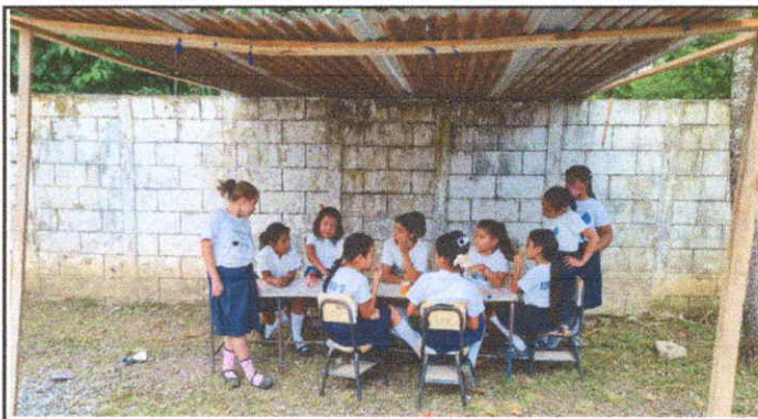
ESTRUCTURA DE TECHO: Renglón 2.2 Sustitución de estructura de soporte de madera por metal.
