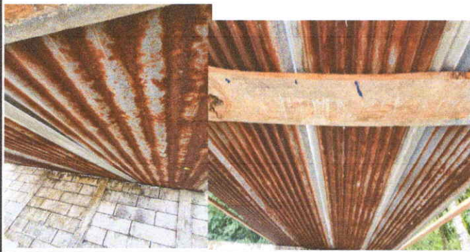
CUBIERTA DE LAMINA: Renglón 1.1 Sustitución de lámina por lámina troquelada aluzinc calibre 26
