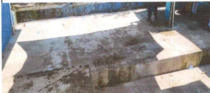
PISO: Renglón 6.6 Sustitución de piso de cemento líquido por piso cerámico.
