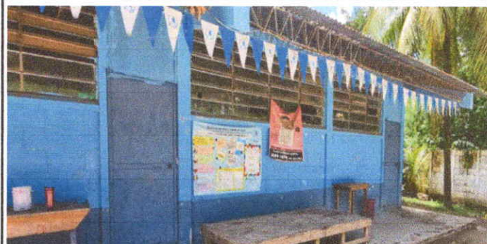
VENTANAS: Renglón 5.2 Sustitución de estructura de metal de ventana por balcones.
