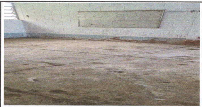
PISO: Renglón 6.6 Sustitución de piso de cemento líquido por piso cerámico.
