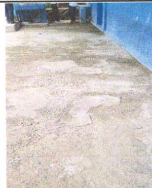
LOSA DE PATIO: Renglón 15.1 Reparación de planchas de concreto de patio.
