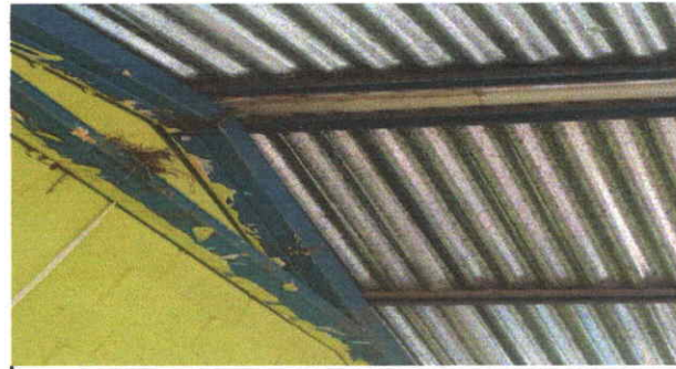
Foto 4: MANTENIMIENTO A ESTRUCTURA SOORTE DE METAL
