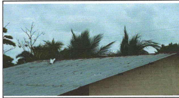
FOTO NO. 2 SUSTITUCION DE LAMINA ACANALADA
