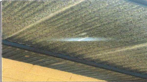
Foto1: SUSTITUCION DE LAMINA ACANALADA
