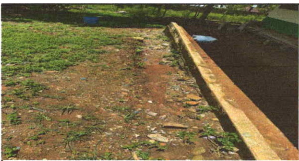
Foto 5: REPARACION DE CUNETAS
