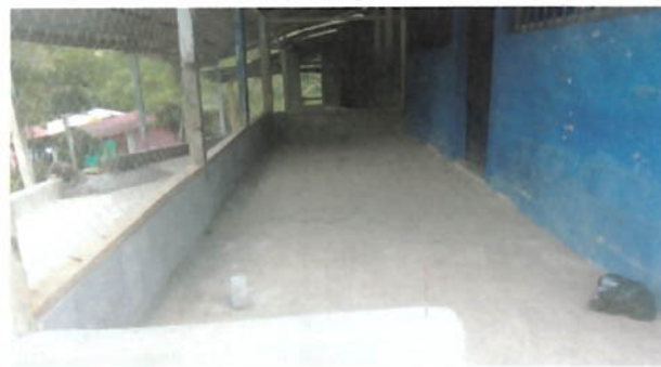
Foto 4: PINTURA EN MUROS INTERIORES Y EXTERIORES
