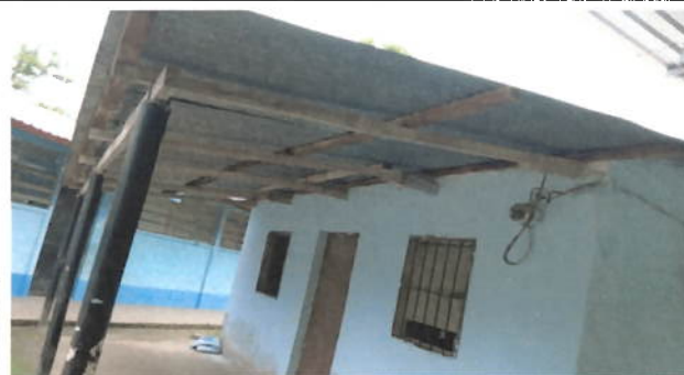
Foto 2: SUSITTUCION DE LAMINA POR LAMINA TROQUELADA DE ALUZIN CALIBRE 26
