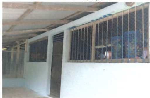
Foto1: SUTITUCIÓN DE BALCONES
