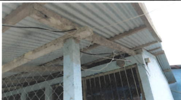
Foto 3: SUSTITUCION DE SOPORTE DE MADERA POR METAL
