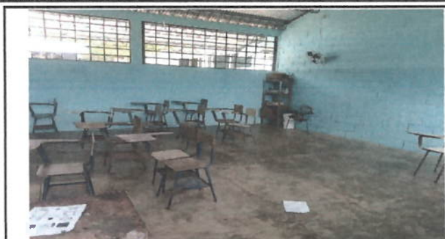
Foto1: SUSTITUCION DE PISO CERAMICO
