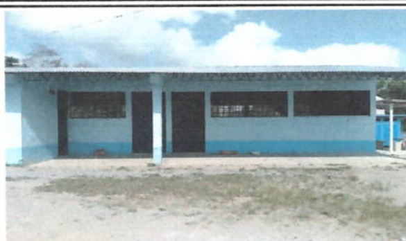
Foto 2: SUSTITUCION DE VENTANAS POR PVC MAS VIDRIOS
