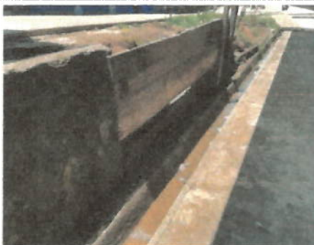
Foto 4: REPARACION DE MURO Y DRENAJES
