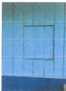
Foto 5: SUSTITUCION DE VENTANAS DE MADERA POR METAL
