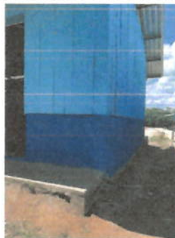
Foto 2: REPARACION DE PLANCHAS DE CONCRETO DE PATIO DEL AULA DE PREPARATORIA
