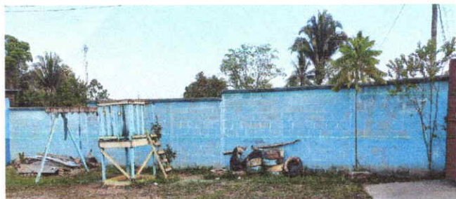
REPELLO Y PINTURA EN MURO PERIMETRAL
