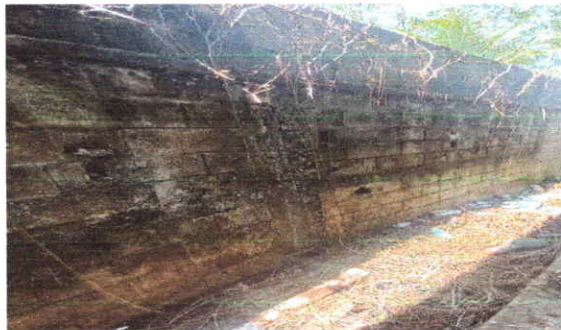
SELLADO EN GRIETAS DE MUROS
