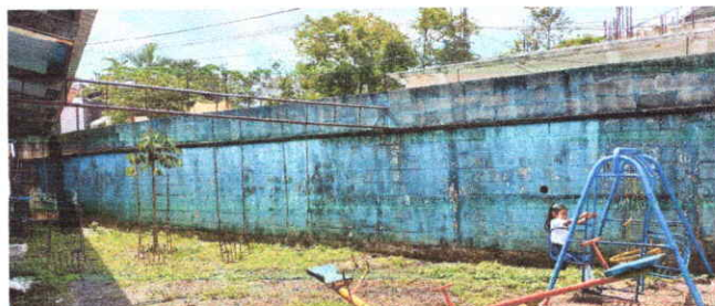
REPELLO Y PINTURA EN MURO PERIMETRAL
