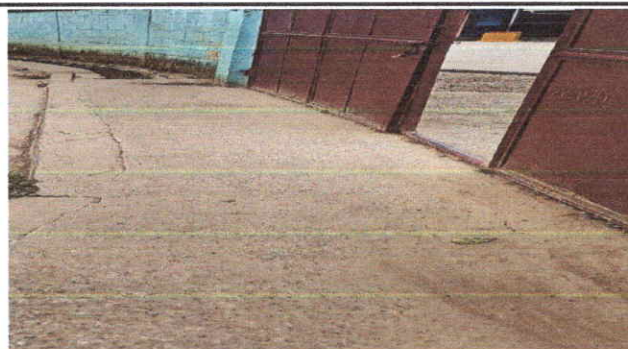
REPARACIÓN DE 10M2 DE BANQUETA DE CONCRETO
