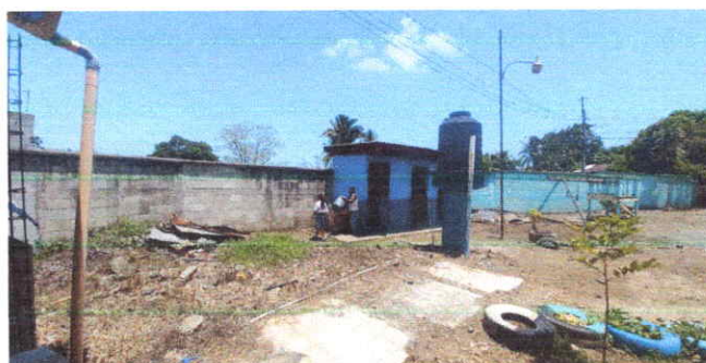
REPELLO Y PINTURA EN MURO PERIMETRAL
