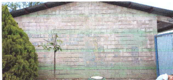
PINTURA EN MURO EXTERIOR DE SALON
