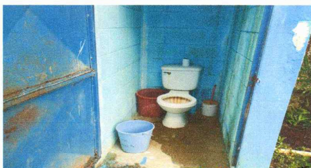
Foto 5: Renglón 10.3 sustitucion de Inodoro
