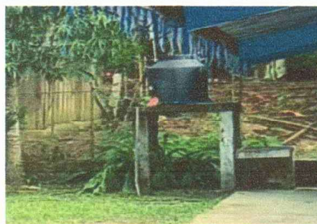
Foto 6: Renglón 18.2 Sustitucion de deposito de Agua 1100 Lts.
