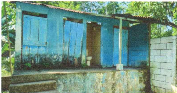
Foto1: Renglón 1.1 Sustitución de lámina por lámina troquelada calibre 26
