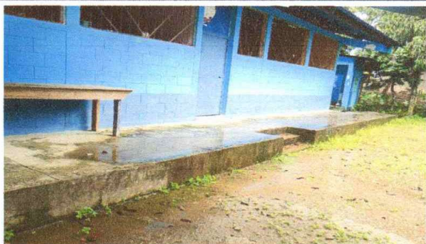
Foto 3: Renglón 6.5 sustitucion de piso de torta de concreto
