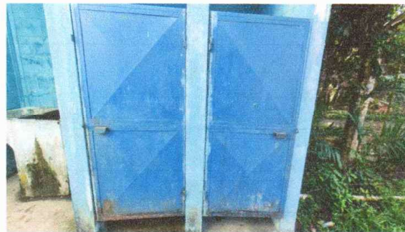
Foto 2: Renglón 4.4 sustitución de puertas en servicio sanitario
