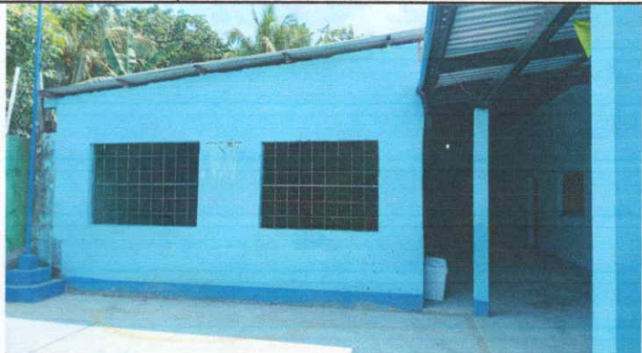
Foto 1: SUSTITUCION DE VENTANA POR VENTANA DE PVC
