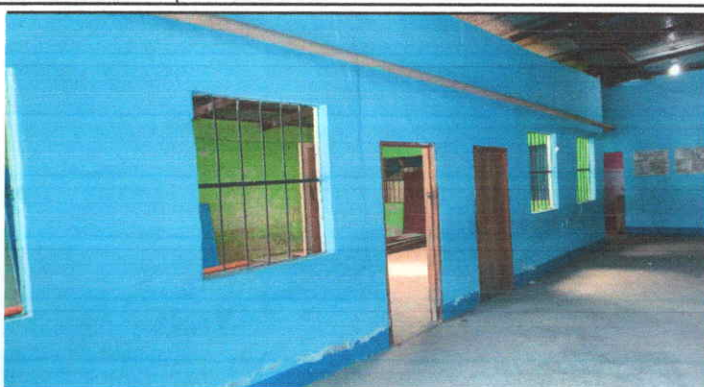
Foto 2: SUSTITUCION DE CIELO FALSO
