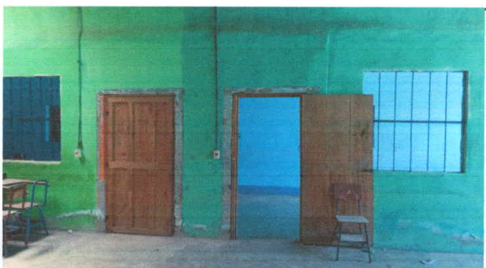
Foto 4: SUSTITUCION DE PUERTAS
