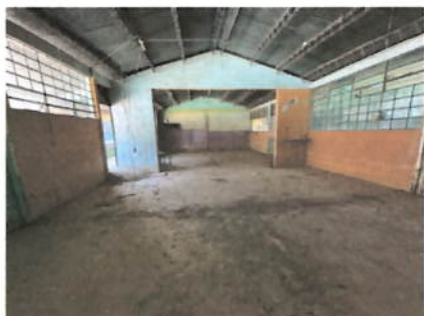
Foto1: Sustitucion de piso de cemento liquido.
