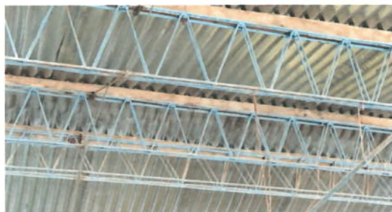
Foto 3: mantenimiento de estructura de metal.
