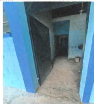
Foto 2: Sustitucion de piso de cemento liquido.
