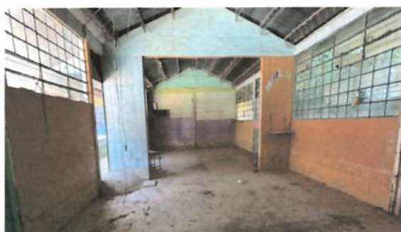
Foto 5: Pintura en muros de interiores.
