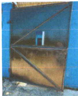
Foto 5: : Mantenimiento de portón de metal 2.50 de alto por 2.10 de ancho
