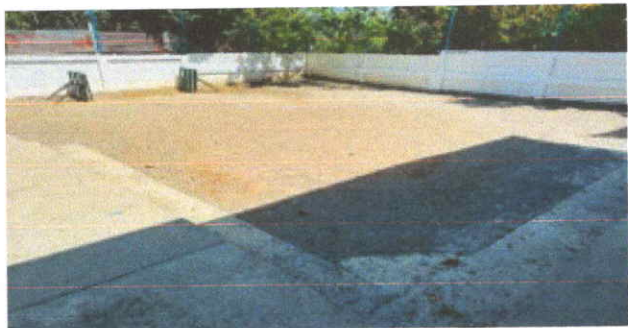
Foto 1: 181 metros cuadrados de piso de concreto
