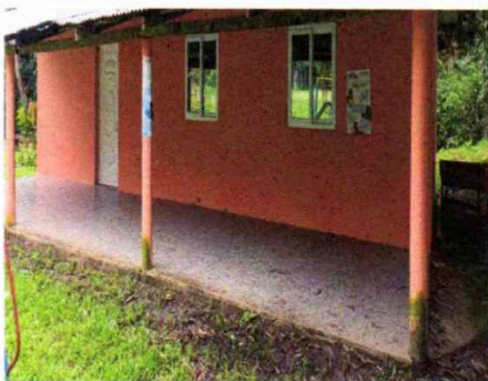
Foto 3: SUSTITUCIÓN DE PISO DE TORTA DE CONCRETO
