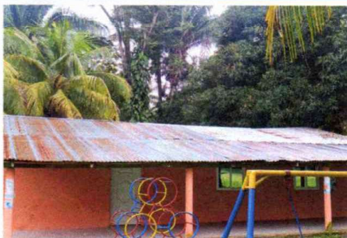
Foto1: SUSTITUCIÓN DE LÁMINA
