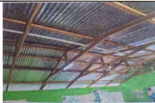
SUSTITUCIÓN DE ESTRUCTURA DE SOPORTE
