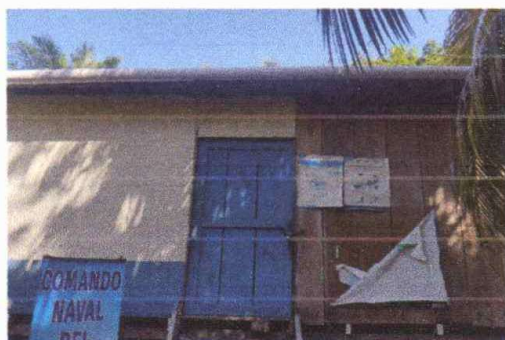
sustitución de tubo pvc con agujeros por canal de agua pluvial upvc.
