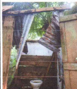
paredes de baños y aulas caídas y podridas.
