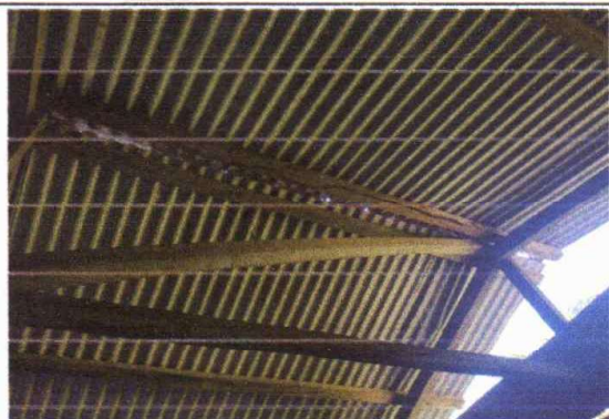
lámina picada e inservible.
