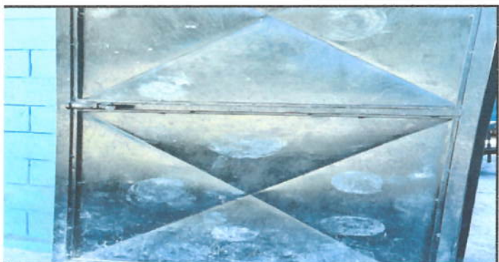
Mantenimiento de estructura
