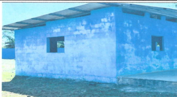
Pintura en muro exterior e interior
