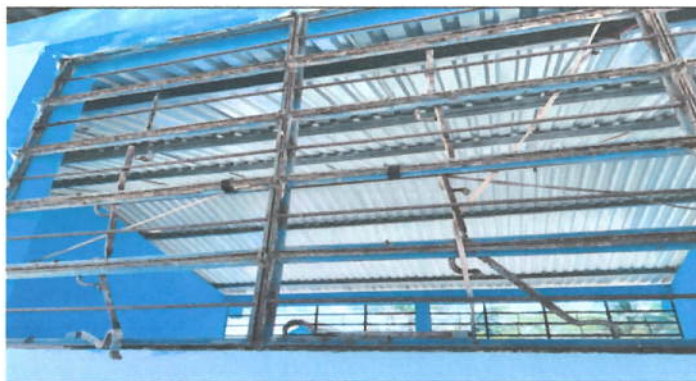
Sustitucion de balcones.
