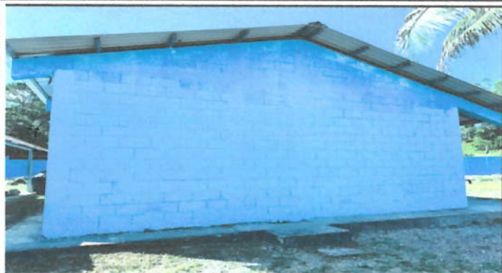
Repello en muro
