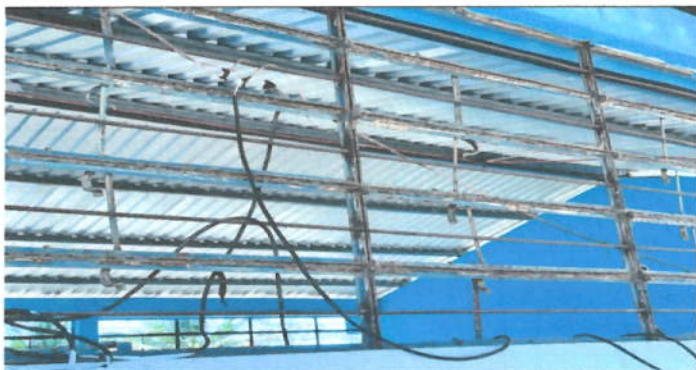
Reparación cableado electrico,
