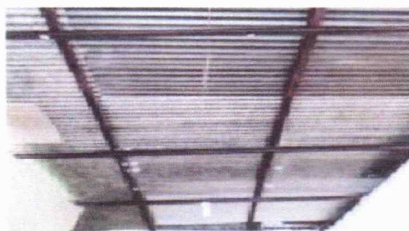
Foto 2: Reparación de techo, lámina y estructura de metal
