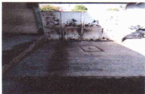
Foto 3: Sustitución de porton principal
