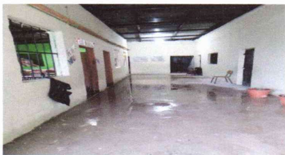
Foto 1: Reparación de techo, lámina y estructura de metal
